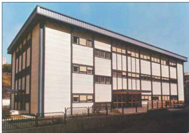
Il nuovo Centro di Cardiocirurgia. L'edificio è stato prefabbricato con strutture portanti in acciaio.
